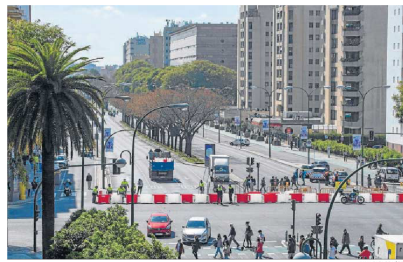
Corte de tráfico en la avenida de San Francisco Javier por las obras de ampliación del tranvía.
