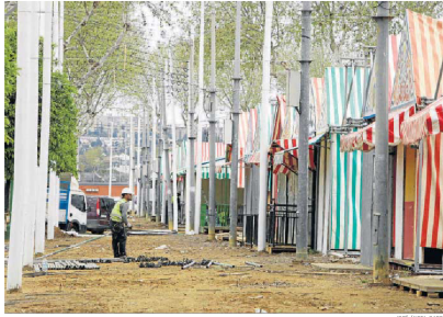
El montaje de las casetas en el real de Los Remedios.
