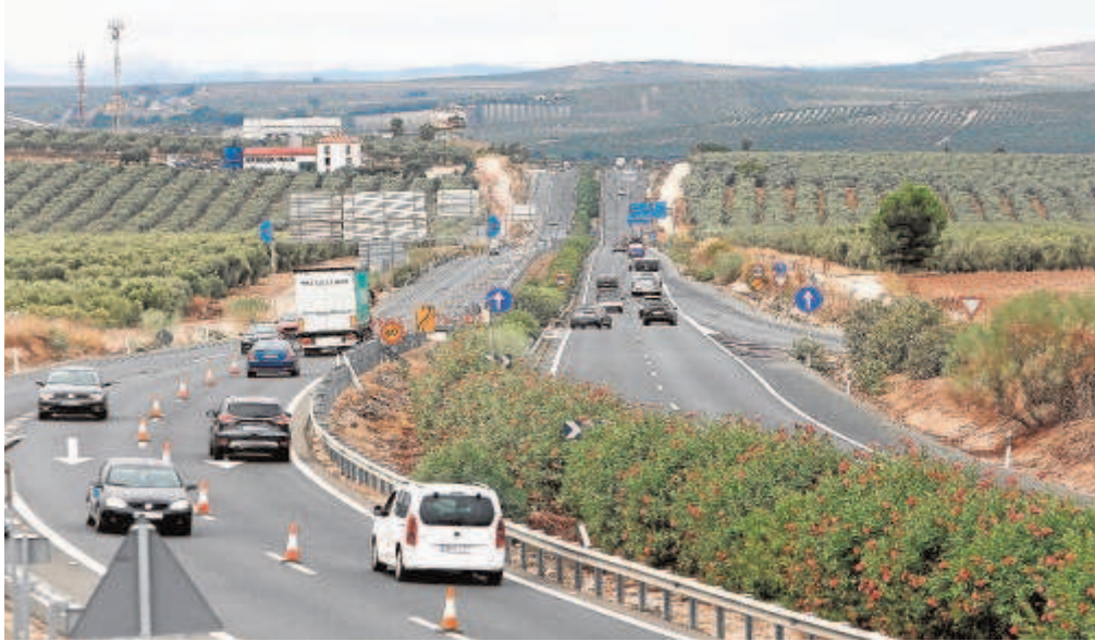
Varios vehículos circulan en las dos direcciones de la A-92 en un tramo en obras de la provincia de Sevilla // ABC
