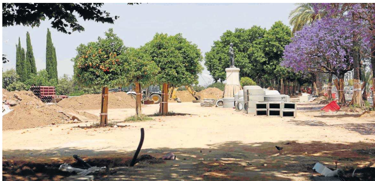
En la transformación que está realizando el Ayuntamiento en el paseo de Torneo colabora la Junta de Andalucía.
