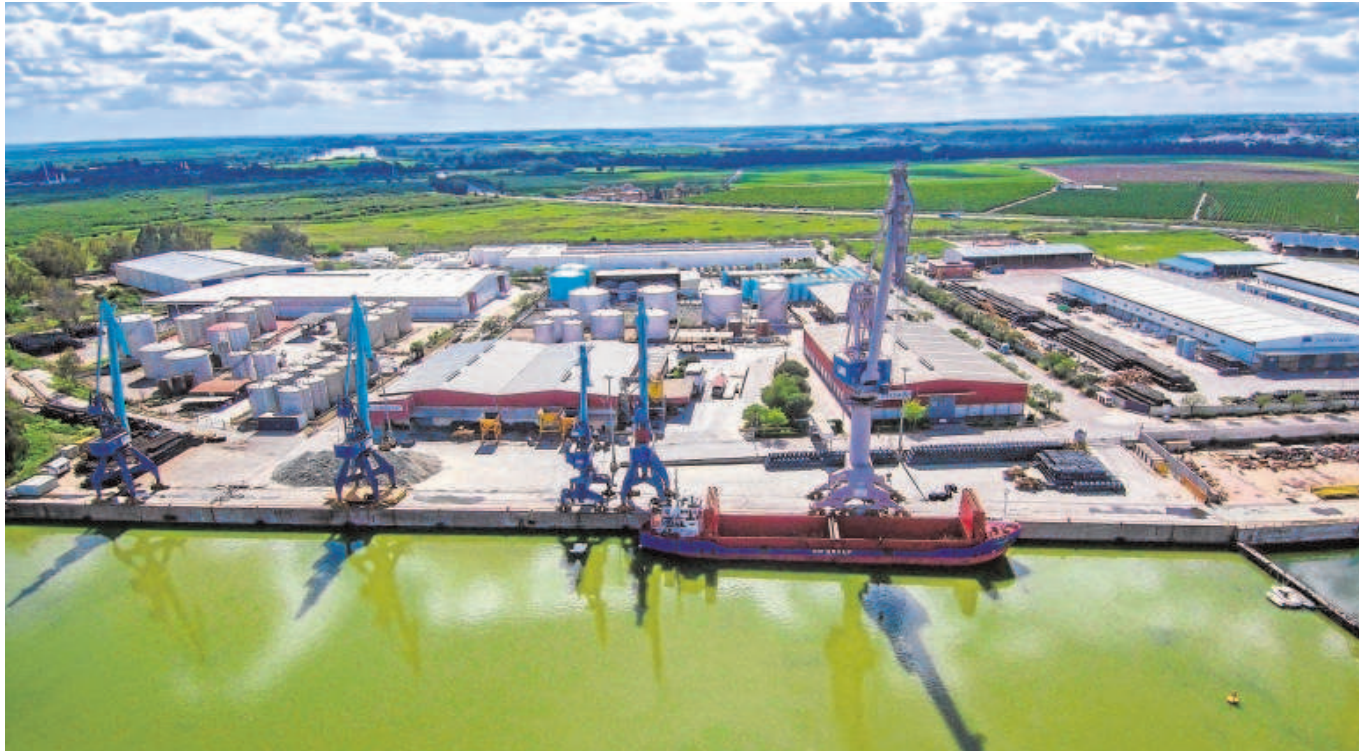
Imagen aérea de las instalaciones de Sevitrade, el mayor concesionario del Puerto de Sevilla // ABC
