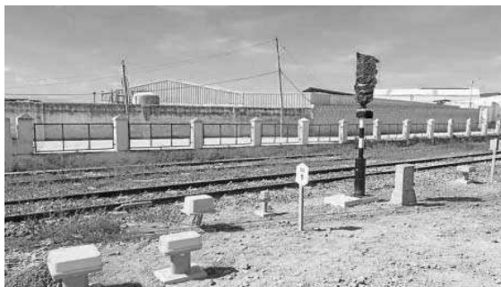
Señal S-21 instalada en Pedrera.
