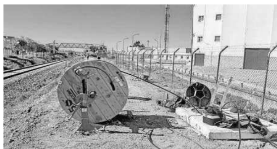
Tendido de cable en canalización.
