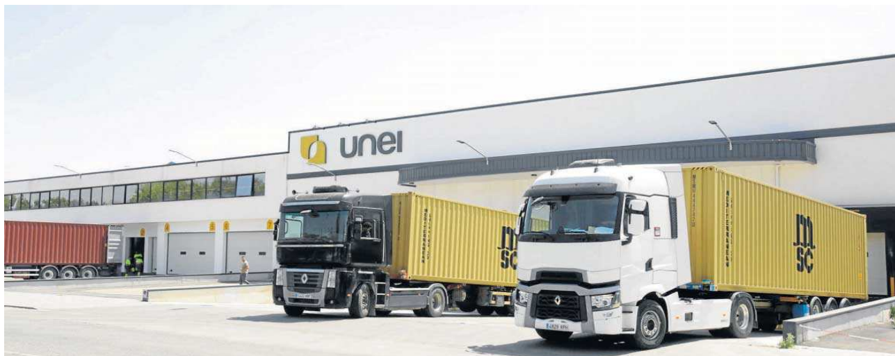
Instalaciones logísticas de Unei en el Polígono Calonge, en Sevilla.
