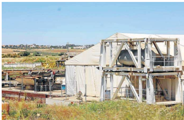
Más piezas de la tuneladora en el exterior de la carpa donde se almacena.
