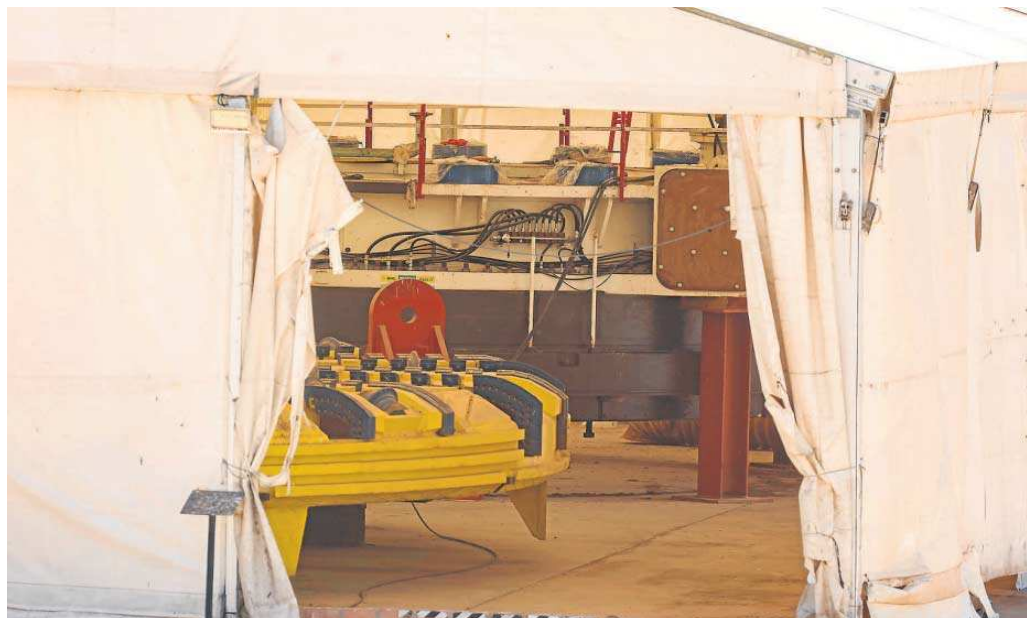
Primer plano de la cebeza giratoria de la tuneladora de la SE-40 almacenada en Coria.
