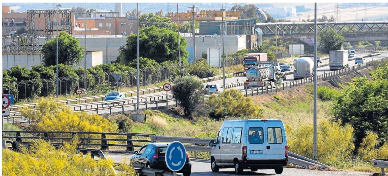
Estado actual de la Supernorte, que une la Isla de la Cartuja con la A-4 a la altura del Parque Alcosa.
