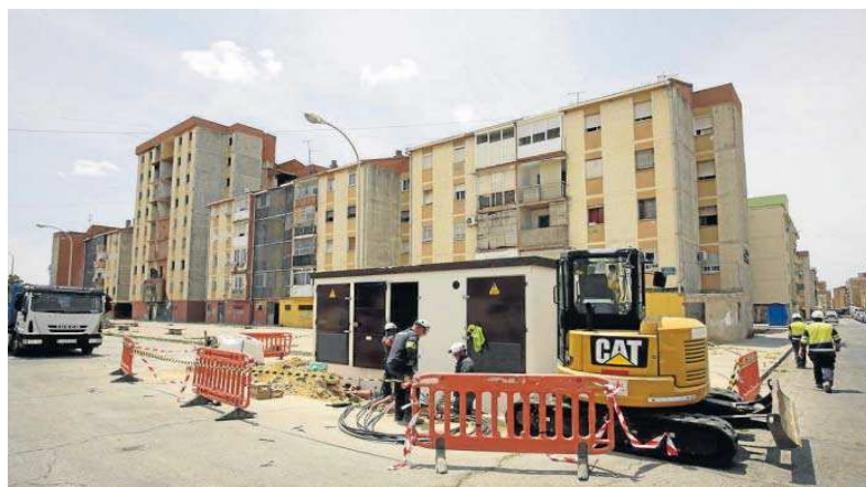
Operarios de Endesa trabajan en el centro de transformación, ayer en el Polígono Sur.
