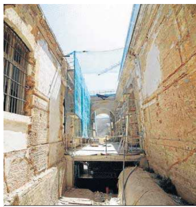
Conducción construida sobre una acequia romana (dcha.)
