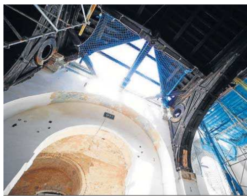
El barrenado horizontal de cañones permitió instalar esta cubierta de madera.
