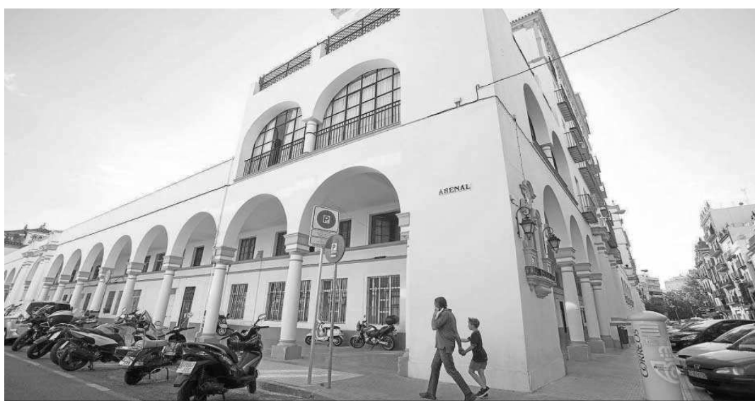
Las obras en el edificio del Mercado del Arenal son de las que se han visto afectadas.
