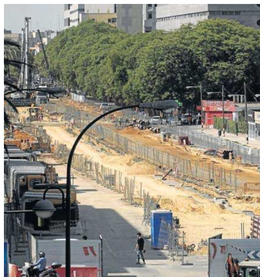
Estado actual de las obras del tranvía en San Francisco Javier.
