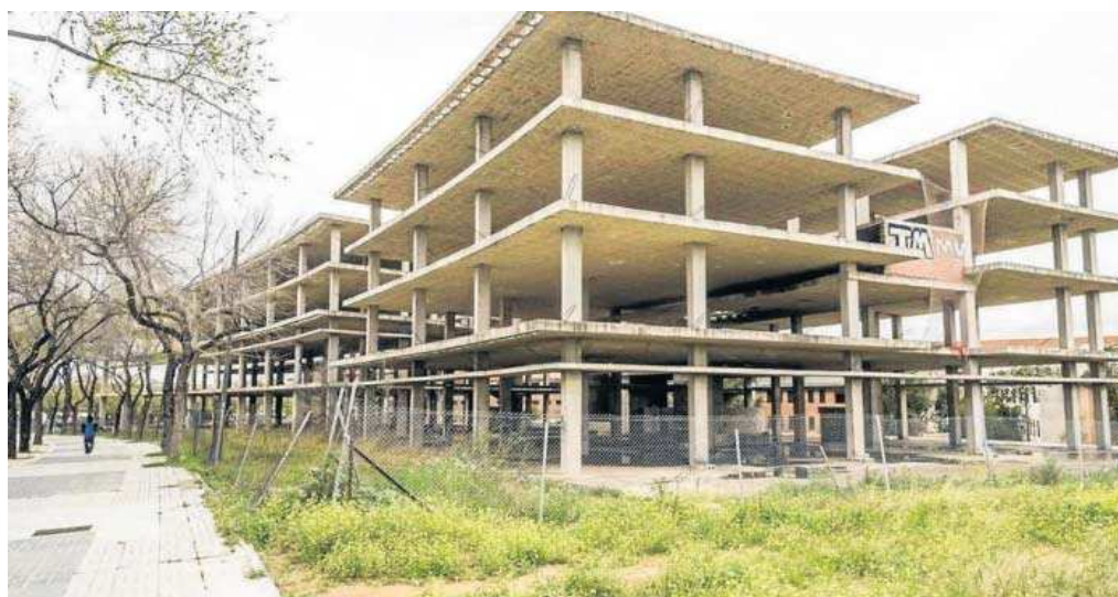
Las estructura de El Esqueleto que se encuentra en Sevilla Este.
