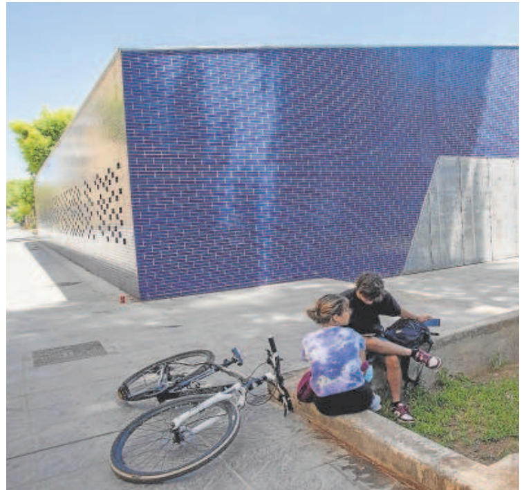
El nuevo edificio del centro de salud Pino Montano A está terminado desde mediados
