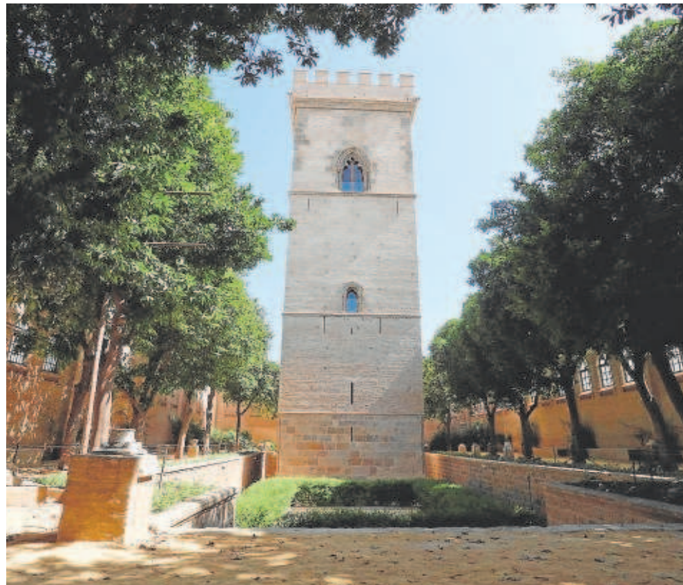
Arriba, la vista general de la Torre de Don Fadrique. A la derecha, detalles de la restauración // FOTOS: VANESSA GÓMEZ
