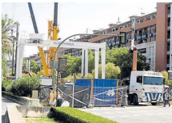
Grúas desmontando la estructura de la tuneladora en Jiménez Becerril.
