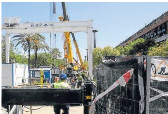
Otra vista del tajo de obra en Jiménez Becerril.
