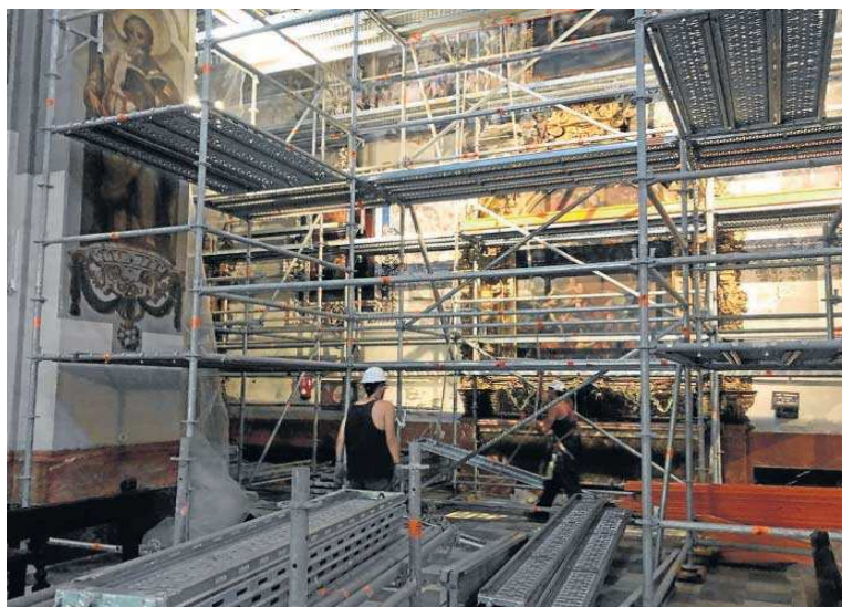
El andamiaje colocado en la nave del Evangelio de la parroquia de la Magdalena.
