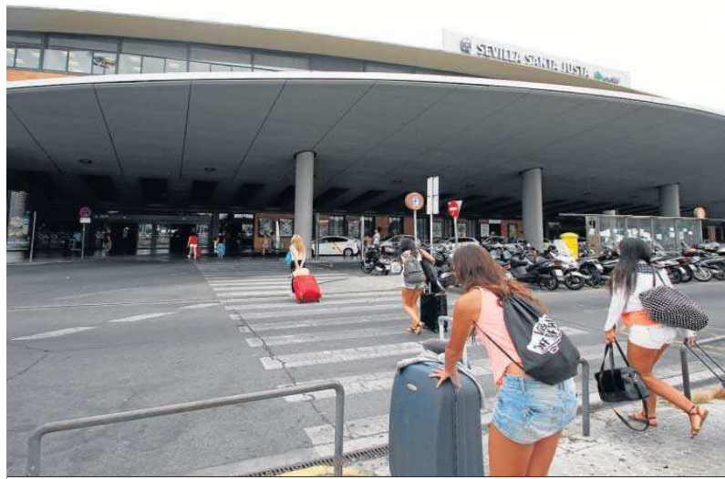
Aspecto actual que presenta el acceso principal a la estación de Santa Justa.
