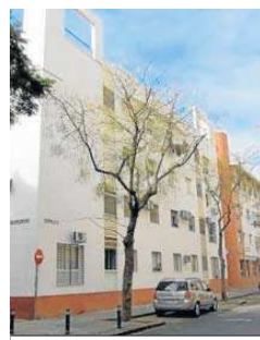
El bloque de Los Bermejales.
