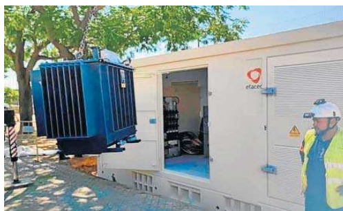
Instalación de un transformador en la calle Bollullos.
