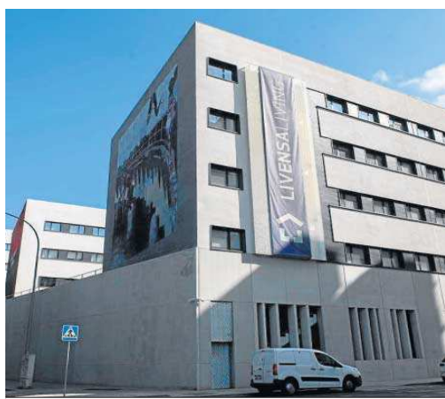
Residencia construida en el solar que ocupaba el Club Antares.
