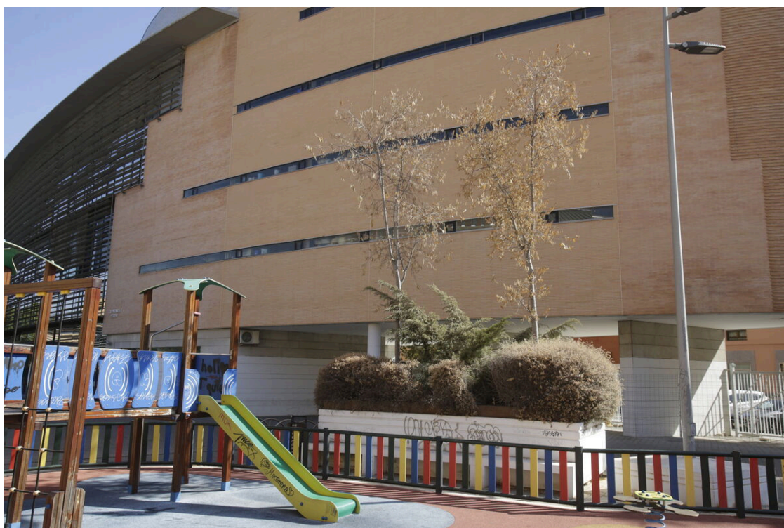
Abandono y mal estado de la plaza entre Mercadona y Plaza de Armas / José Angel García (Sevilla)
