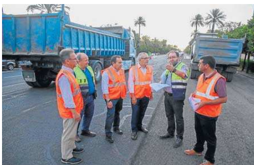
Intervención reciente en la avenida de la Palmera.
