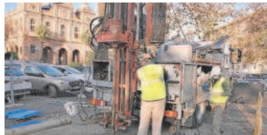
Sondeos para el tramo sur de la línea 3 del metro // J.M.SERRANO
