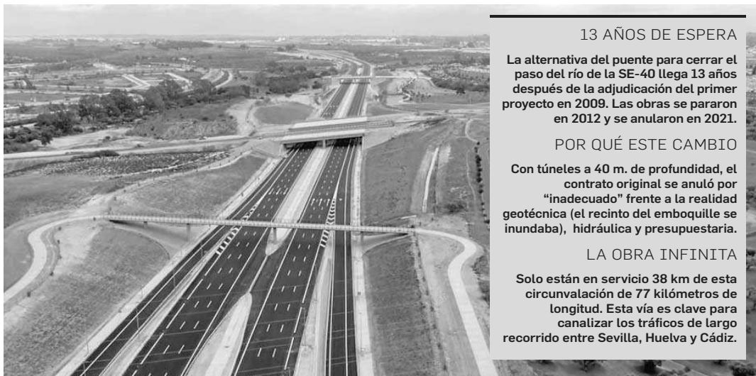
Vista de la SE-40 en el tramo de Dos Hermanas, antes de cruzar el río.
