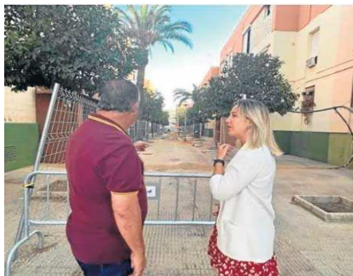
La alcaldesa de Alcalá, Ana Isabel Jiménez, visita las obras de reurbanización.
