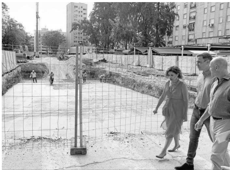
El presidente pasa junto a la valla de las obras de la rampa del túnel del tranvía.
