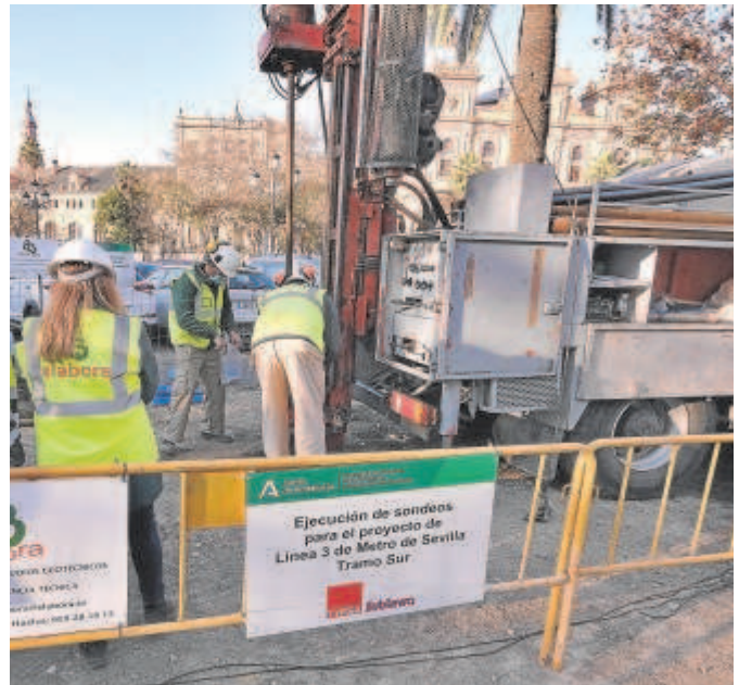
Sondeos para el proyecto de la línea 3 de Metro de Sevilla // J.M.SERRANO
