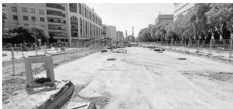
La colocación de las vías del tranvía en Nervión está prevista para las próximas semanas.
