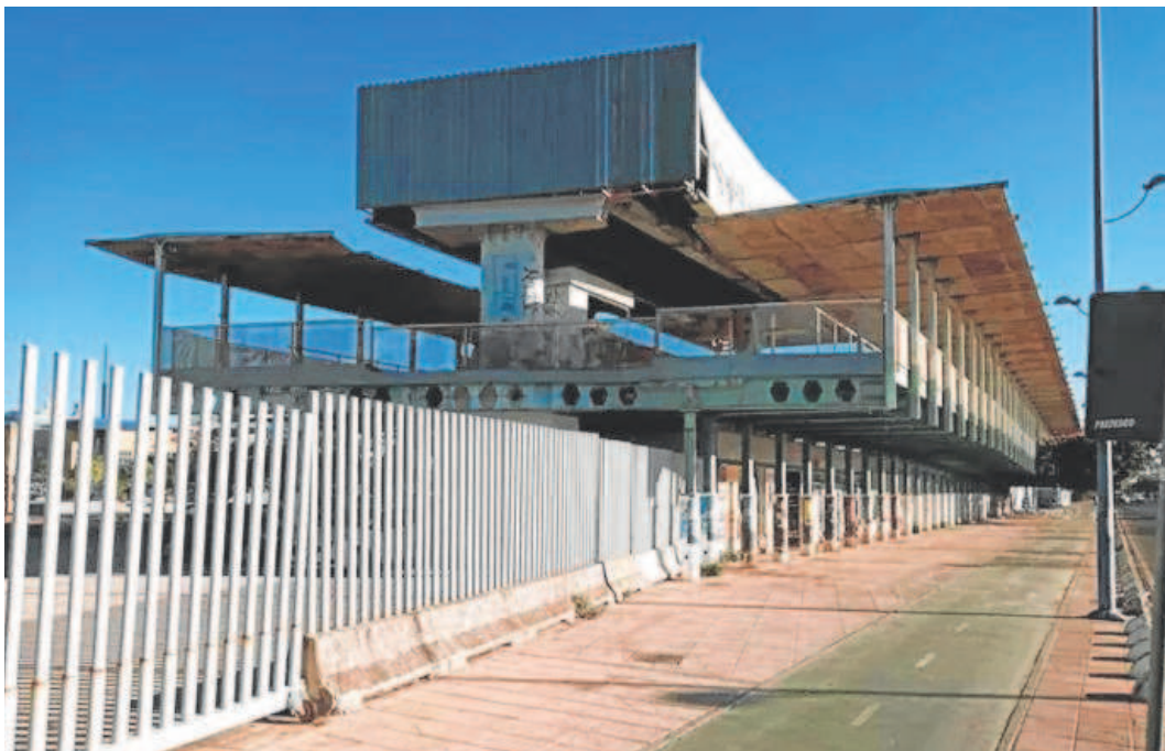
La estación intermedia del telecabin de la Expo, situada en el Camino de los Descubrimientos, será demolida // EP
