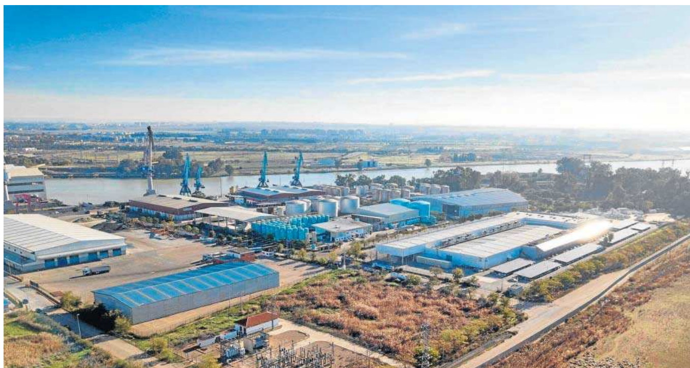
Vista de la zona franca del Puerto de Sevilla.
