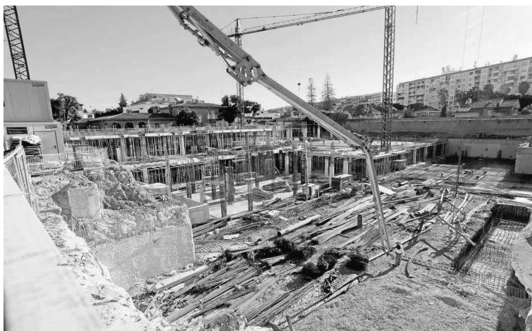
Estado de la obra del número 38 de la Avenida de la Palmera.
