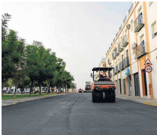
Imagen de una de las calles asfaltadas por el Ayuntamiento.
