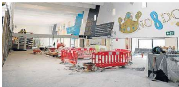
Obras que aún se ejecutan.
