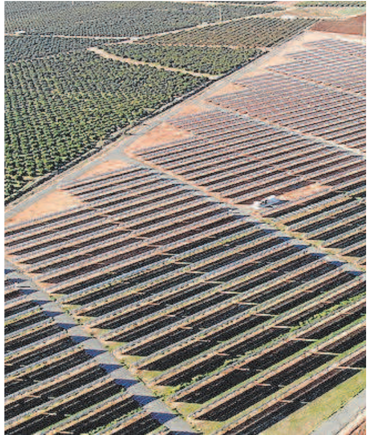
Instalación de energía renovable de la comunidad de regantes del Valle Inferior
