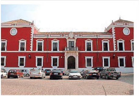
FERNÁN-NÚÑEZ Obras de restauración, consolidación y puesta en valor del Palacio Ducal 1.356.729 €
