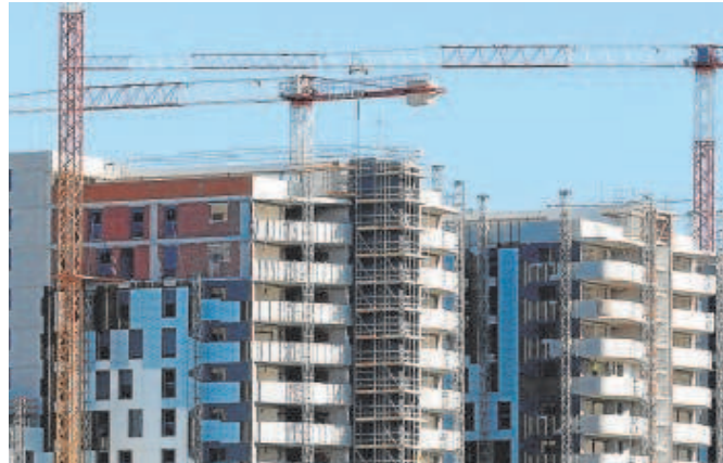
Promoción de viviendas en construcción en Valencia //EFE
