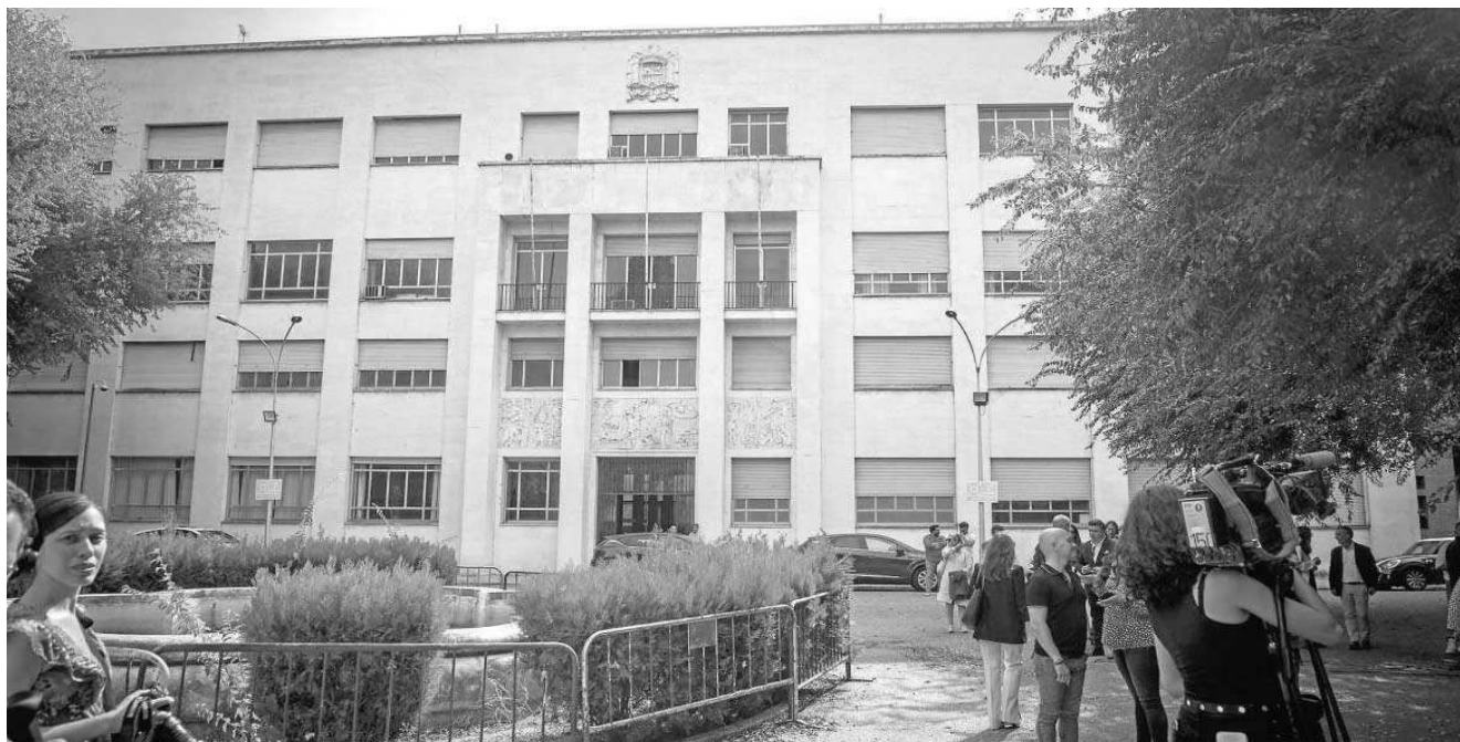
Fachada del edificio principal de Altadis, conocido como El Cubo.
