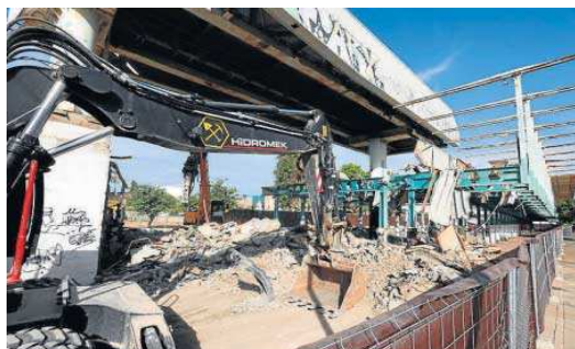
Una máquina trabaja en la demolición de la estación.
