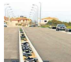
Un vial en ejecución en Espartinas.
