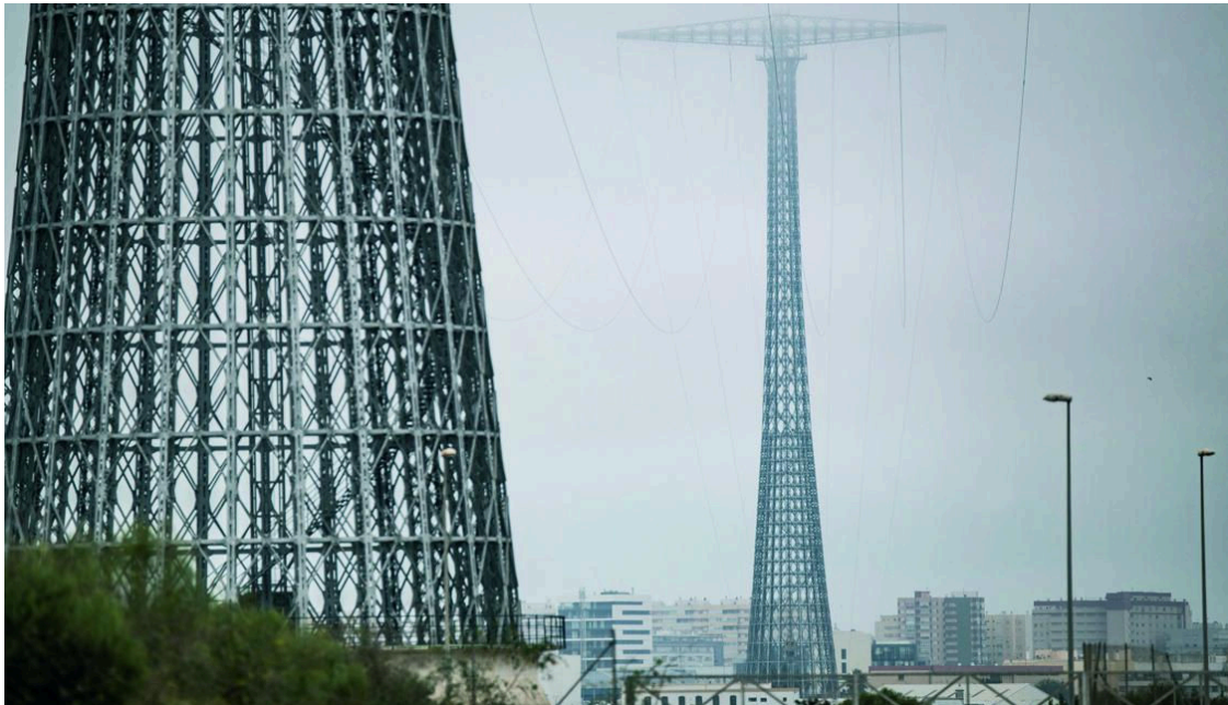
Las emblemáticas torres de la Bahía que permiten la conexión eléctrica de Cádiz y Puerto Real.
