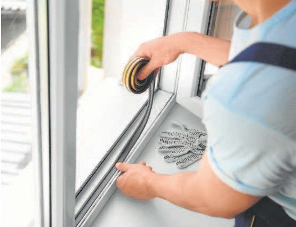
Un técnico cambia el cerramiento de una ventana, una de las obras que cubren las ayudas de la Junta // ABC
