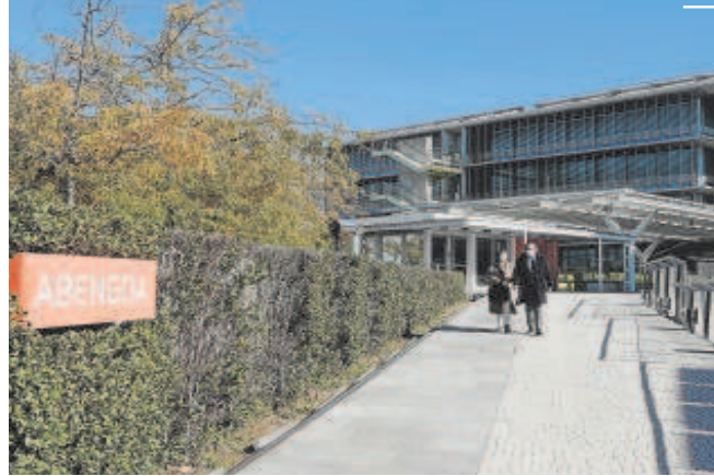
Sede de Abengoa en Palmas Altas, en Sevilla // RAÚL DOBLADO
