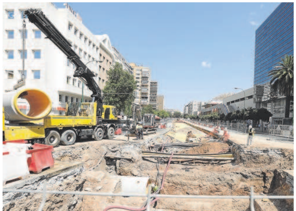
Obras en la avenida de San Francisco Javier // RAÚL DOBLADO
