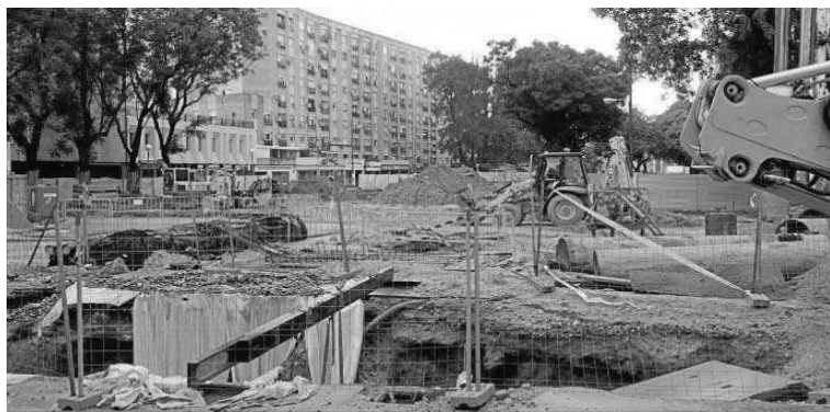
Otra vista de las zanjas abiertas en la esquina de Ramón y Cajal con San Francisco Javier.
