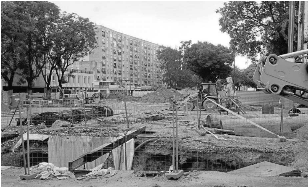
Zanjas de la obra del tranvía en la esquina de Ramón y Cajal con San Francisco Javier.
