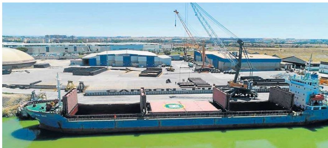
Instalaciones de la terminal ferroviaria de Carbón Puerto en Sevilla, con casi 9 hectáreas, donde operará Euroports.
