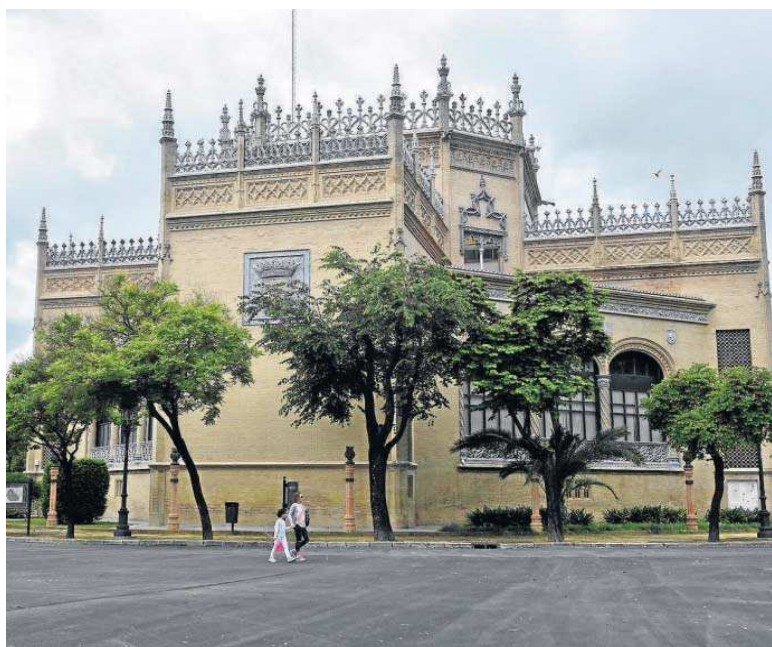
Vista del Pabellón Real desde la entrada al parque por la Borbolla.
