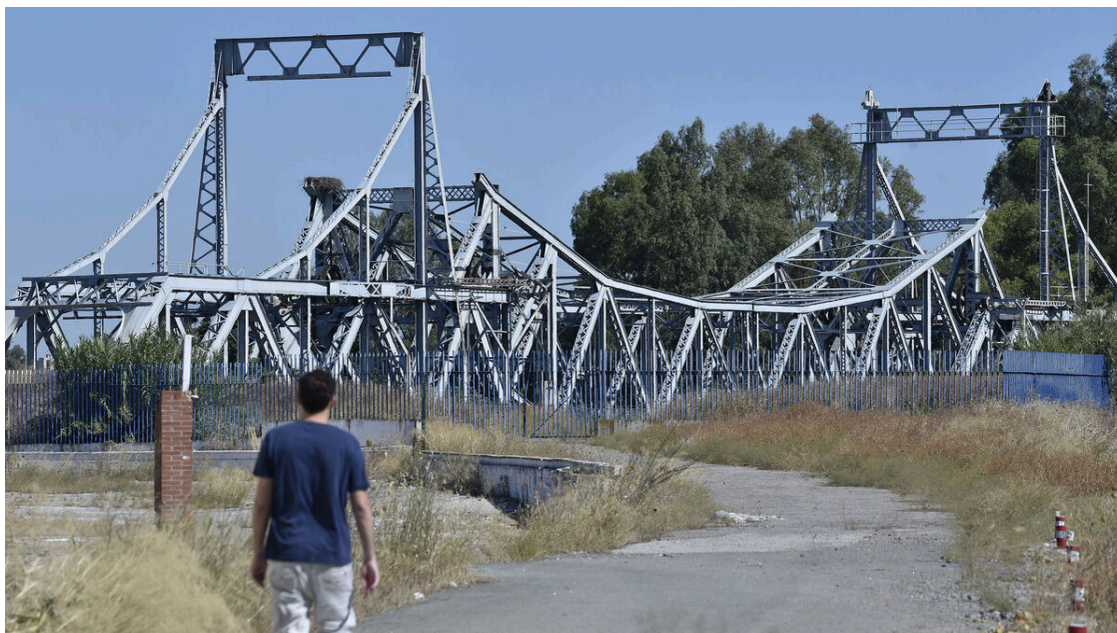
El puente de hierro abandonado en un solar de la Avenida de las Razas. / José Ángel García
