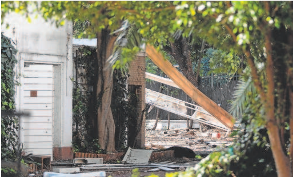
Abandono que presenta el antiguo restaurante tras los expolios que ha sufrido en pleno Parque // VANESSA GÓMEZ
