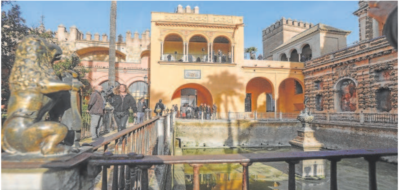
Vista del estanque de Mercurio en el Real Alcázar, antes del inicio de las obras de restauración de este espacio // RAÚL DOBLADO
