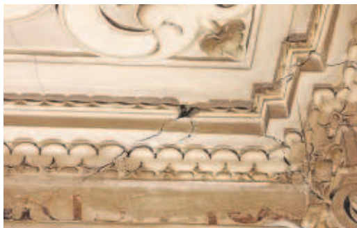
Detalles de las diversas grietas que se observan en los techos de la iglesia de San Jorge del Hospital de la Caridad, así como las humedades que están afectando a las yeserías en concreto, a detalles como los motivos frutales que se hallan al lado de las pinturas de Valdés Leal o Murillo y en los retablos de Simón de Pineda // FOTOS: RAÚL DOBLADO
