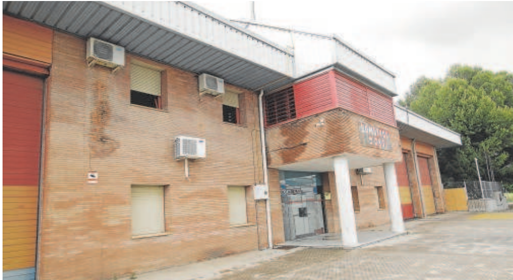
Exterior del parque de bomberos de la Carretera Amarilla // JUAN FLORES
