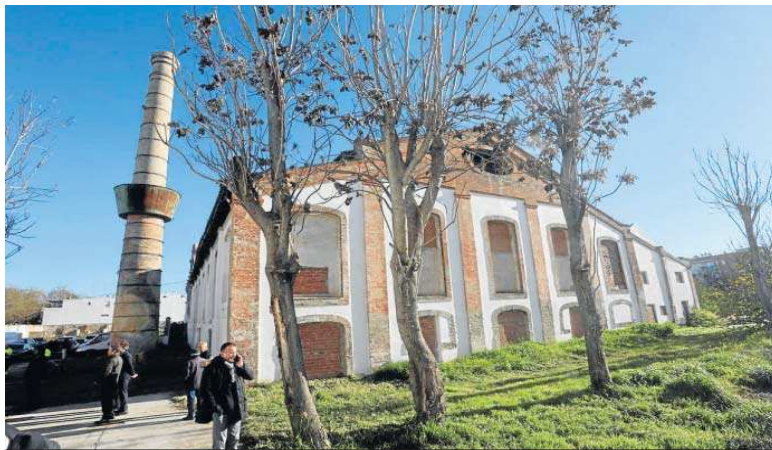
Varias personas ayer en el inicio de las obras en la antigua fábrica de Vidrio de la Trinidad.
