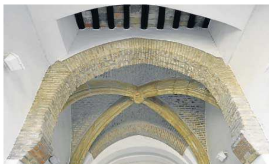
La bella cúpula del interior del postigo.
