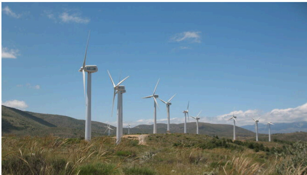
Parque eólico de Endesa en Almería
