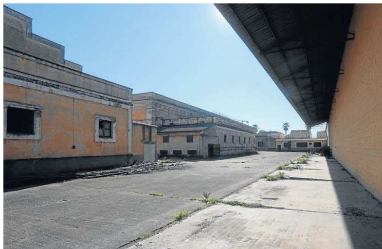
Estado actual del exterior de la antigua fábrica de artillería.
