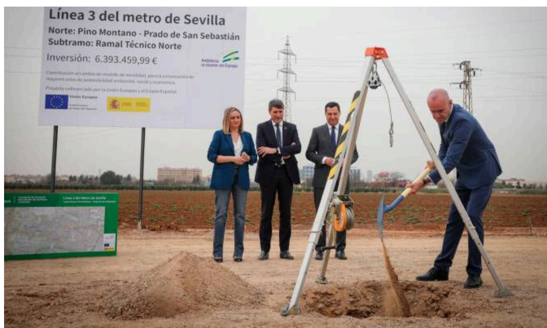
El alcalde de Sevilla, Antonio Muñoz, durante la colocación de la primera piedra del ramal técnico del tramo norte de la línea tres del metro de Sevilla. María José López / Europa Press
