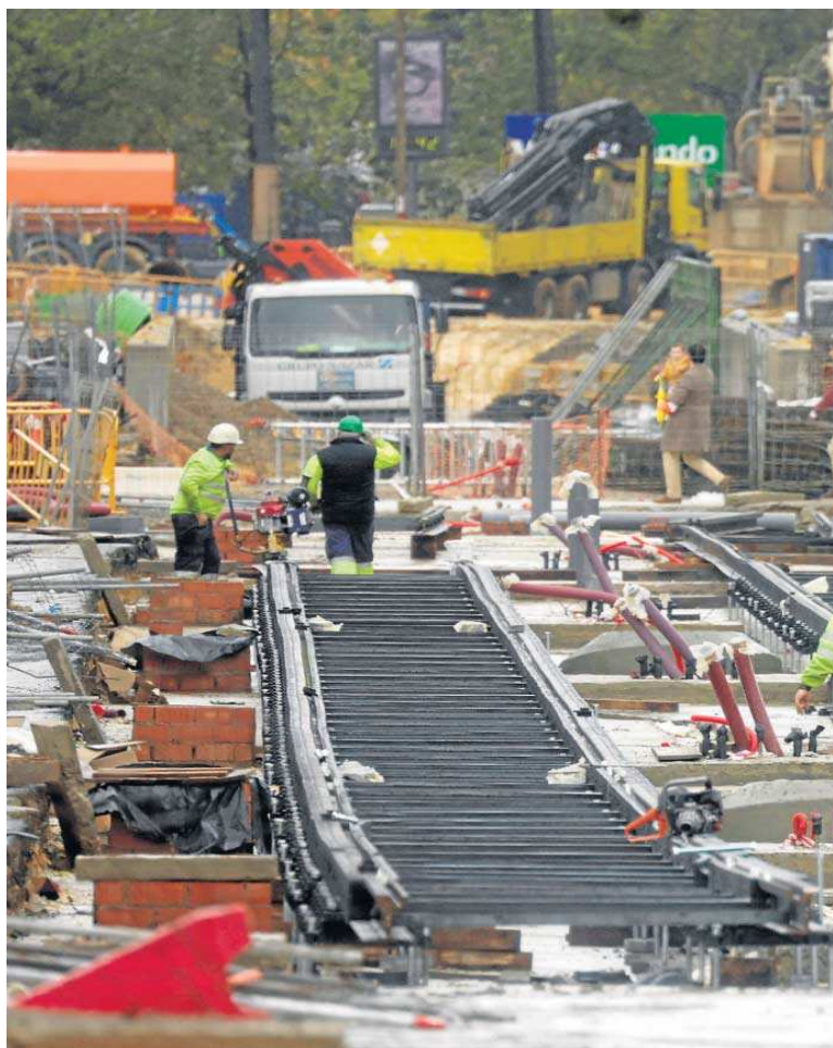
Colocación de vías en un tramo de San Francisco Javier.
