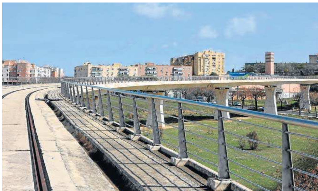
Estado actual del viaducto del tranvía que entra en Alcalá.
