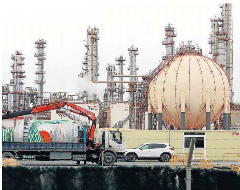
Instalaciones de una refinera en la provincia de Huelva.
