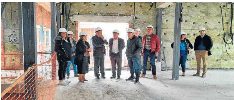
Durante su visita a El Ronquillo, Villalobos y el alcalde han comprobado el avance de la obra de la nueva Casa Consistorial.
