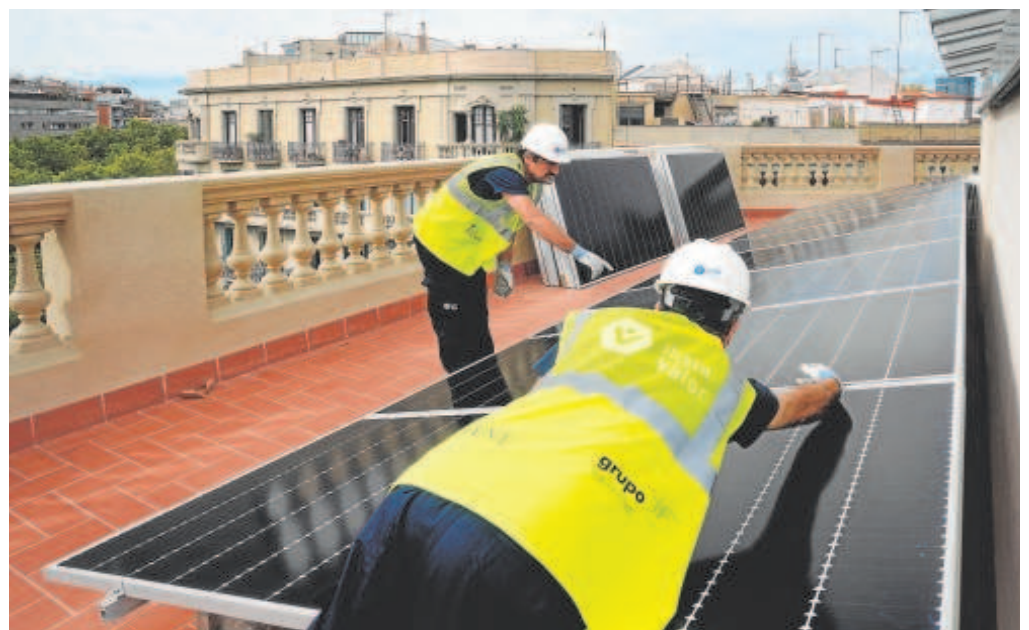
Instalación de paneles solares en un edificio en Barcelona // EFE
